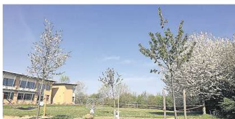
Aus dem von der Gesamtschule erhofften Anbau ans Schulzentrum wird wegen des angrenzenden Landschaftsschutzgebietes vorerst nichts. FOTO: GT
